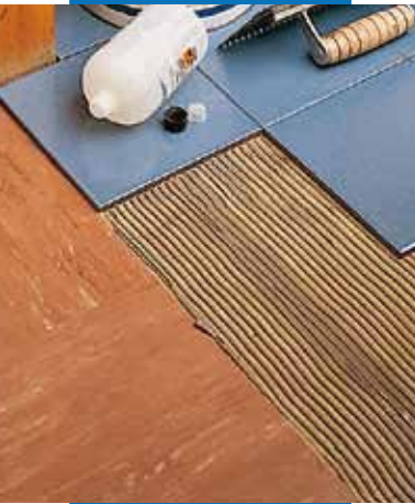
Укладка на старое ПВХ покрытие
