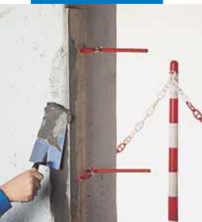
Ремонт вертикальной кромки с помощью Nivorapid
