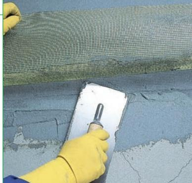
**Двухкомпонентный эластичный гидроизоляционный состав на цементной основе.**
