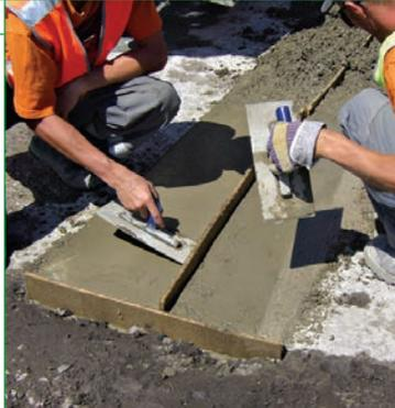
**Безусадочная быстротвердеющая бетонная смесь, содержащая полимерную фибру, предназначенная для ремонта бетонных и железобетонных элементов конструкций мостов, аэродромных и дорожных покрытий. Максимальный размер заполнителя 10 мм. Толщина нанесения от 50 до 300 мм.**
