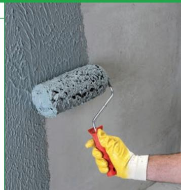
**Двухкомпонентная эластичная гидроизоляция на цементной основе для бетонных конструкций, подверженных отрицательному и положительному давлению воды.**
