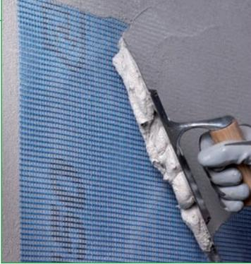
**Однокомпонентный цементный раствор с высокой адгезионной прочностью для выравнивания и финишной отделки неровных и шероховатых оснований, кирпичной кладки и бетонных стен внутри и снаружи помещений.**
