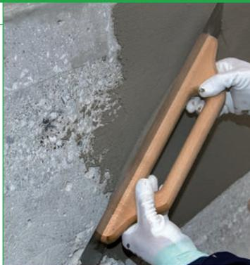
**Быстрохватывающаяся выравнивающаяся смесь на цементной основе для горизонтальных и вертикальных оснований внутри и снаружи помещений с толщиной нанесения от 3 до 30мм.**
