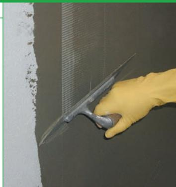
**Однокомпонентный цементный состав для приклеивания теплоизоляционных материалов и создания армирующего слоя в наружных системах теплоизоляции.**
