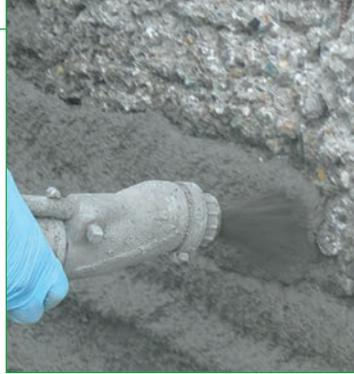
Однокомпонентная сульфатостойкая тиксотропная ремонтная смесь на цементной основе с компенсированной усадкой, армированная неорганической фиброй для ремонта бетонных конструкций.
