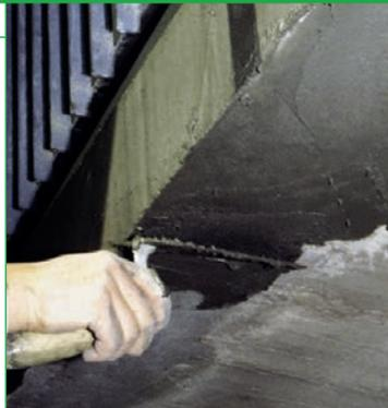
Быстротвердеющая ремонтная смесь с компенсированной усадкой, тиксотропного типа, средней прочности (40 МПа), содержащая полимерную фибру, предназначенная для ремонта бетонных и железобетонных конструкций.
