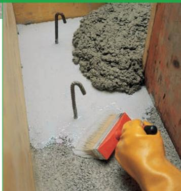
**Двухкомпонентный эпоксидный клей без содержания растворителей для соединения конструкций и монолитного заполнения трещин в основании.**
