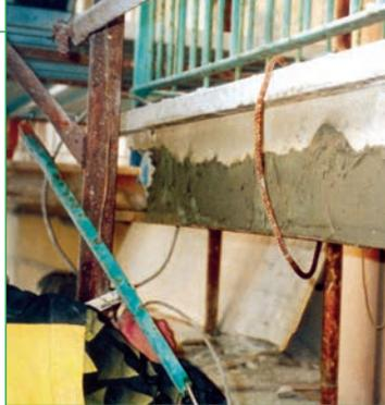
**Быстросхватывающаяся тиксотропная ремонтная смесь с контролируемой усадкой для ремонта и финишного выравнивания бетонных поверхностей (толщина нанесения 1-40 мм).**
