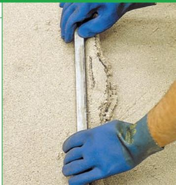
Трехкомпонентный эпоксидный состав, стойкий к кислотам, для изготовления толстослойных износостойких покрытий.
