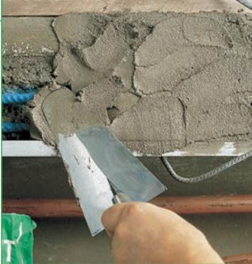
**Быстросхватывающаяся и быстротвердеющая ремонтная смесь с контролируемой усадкой, армированная фиброй.**
