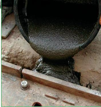
Трехкомпонентный эпоксидный состав для ремонта бетона, точной анкеровки и усиления промышленных полов.
