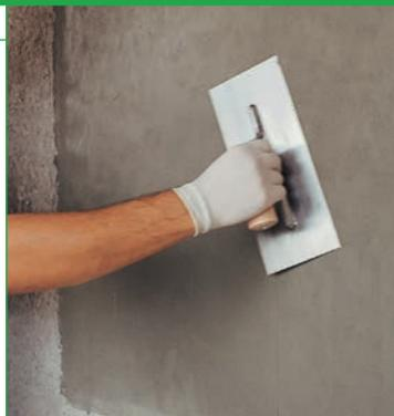
**Финишная шпатлевка на цементной основе для «свежей» или выдержанной штукатурки, применяется внутри и снаружи помещений, с толщиной нанесения до 3 мм.**
