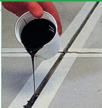
**Двухкомпонентный эластичный самовыравнивающийся герметик стойкий к углеводородам на основе полиуретановых и углеводородных смол.**
