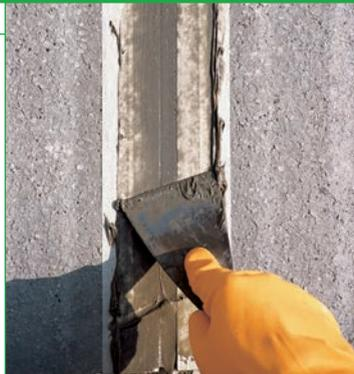
Двухкомпонентный тиксотропный эпоксидно-полиуретановый герметик с высокой химической стойкостью и механической прочностью.
