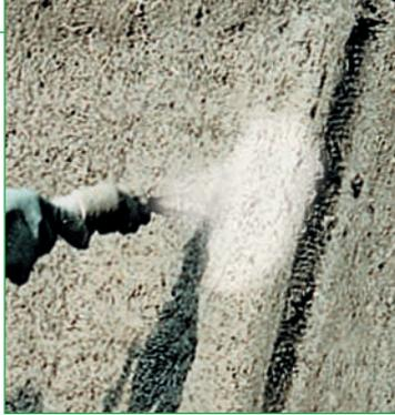
Быстротвердеющая ремонтная смесь с компенсированной усадкой, тиксотропного типа, содержащая полимерную и гибкую стальную фибры, предназначенная для ремонта бетонных и железобетонных конструкций.
