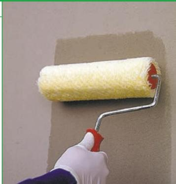
**Модифицированная вододисперсионная грунтовка на основе силиката калия для обработки сильновпитывающих оснований.**
