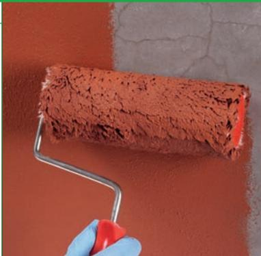
**Цветная вододисперсионная грунтовка-краска на основе силиката калия с высокой укрывающей способностью, для выравнивания поверхностей. Соответствует стандартам DIN 18363.**
