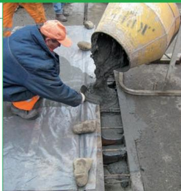
Высокотекучая быстротвердеющая ремонтная смесь с компенсируемой усадкой, содержащая полимерную и стальную латунированную фибру, предназначенная для конструкционного ремонта бетонных и железобетонных конструкций. Толщина нанесения от 20 до 60 мм.
