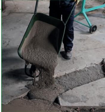
**Быстрохватывающаяся и быстротвердеющая высокотекучая ремонтная смесь с контролируемой усадкой, применяемая для ремонта бетона при пониженных температурах до -5°C. Используется в сочетании с жесткой стальной фиброй.**
