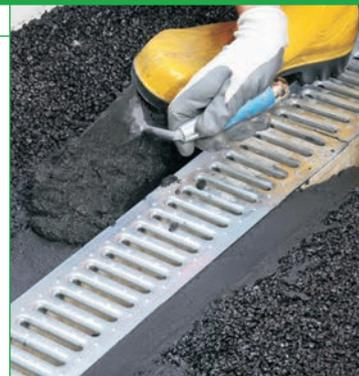
Быстросхватывающаяся и быстротвердеющая тиксотропная ремонтная смесь с компенсированной усадкой, применяемая для ремонта бетона и монтажа дренажных труб, канализационных люков и городских декоративных элементов.
