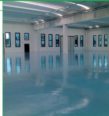
**Двухкомпонентная эпоксидная грунтовка для защиты бетона.**
