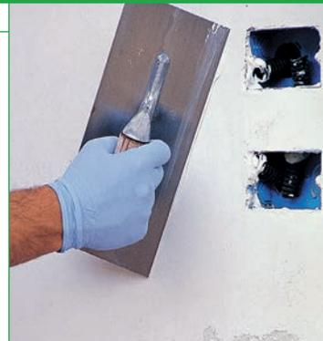
**Известково-цементная шпатлевка для финишного выравнивания штукатурок при наружных и внутренних работах, наносится способом «свежее по свежему» слоем толщиной до 3 мм.**
