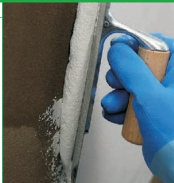
**Выравнивающий состав на основе извести и цемента для «свежей» или выдержанной штукатурки, применяемый внутри и снаружи помещений, с толщиной нанесения до 3 мм.**
