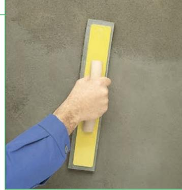
**Двухкомпонентный цементный состав для защиты и финишной отделки бетона**
