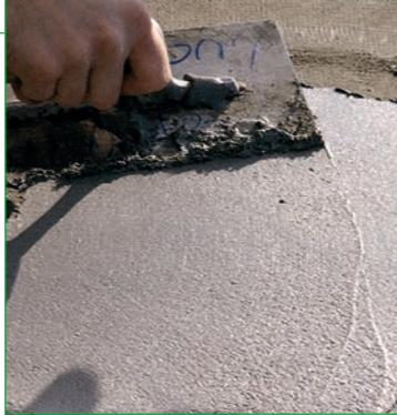
**Тонкослойный быстросхватывающийся состав светло-серого цвета, для ремонта и выравнивания горизонтальных и вертикальных поверхностей бетона и штукатурки.**
