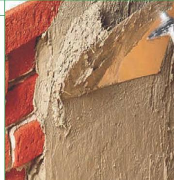
Двухкомпонентный высокоэластичный армированный фиброй цементный состав, предназначенный для выравнивания поверхности из камня, кирпича и туфа перед укладкой сеток **Mapegrid G 120** и **Mapegrid G 220**. Максимальная толщина слоя 25 мм.
