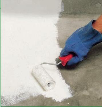
**Эпоксидная двухкомпонентная краска для химической защиты бетона.**
