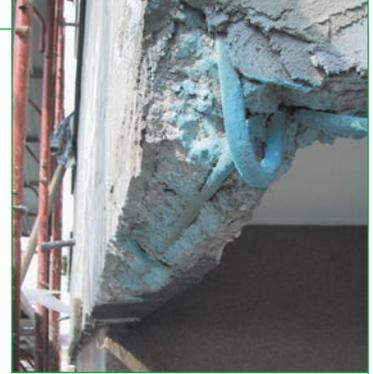
**Однокомпонентный цементный состав для защиты арматурных стержней от коррозии.**
