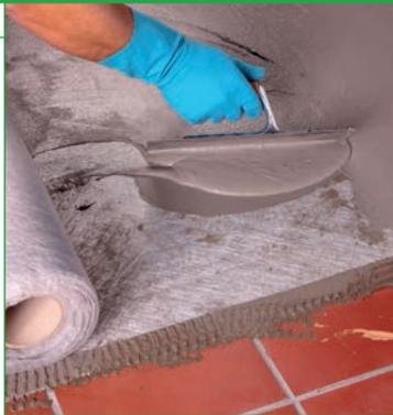
**Нетканое, полипропиленовое полотно с макроотверстиями для систем гидроизоляции.**
