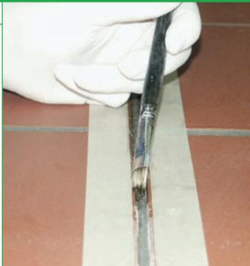
Однокомпонентный прозрачный эпоксидно-изоциановый грунтовочный состав на основе растворителей для нанесения на впитывающие поверхности.
