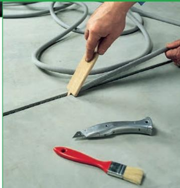
Шнур круглого сечения из прессованного пенополиэтилена для коррекции размерности деформационных швов.
