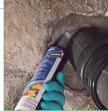
Однокомпонентная герметизирующая паста, расширяющаяся под действием воды, используемая для гидроизоляции и заполнения трещин в бетоне.
