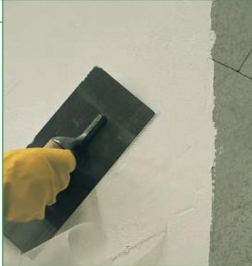
Однокомпонентная высокоэластичная, армированная фиброй, шпатлевка для оштукатуренных поверхностей и очень тонких потрескавшихся фактурных покрытий, при условии, что они однородные и загрунтованные.
