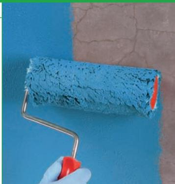
**Цветная вододисперсионная грунтовка на основе силиконовых смол предназначена для выравнивания и подготовки оснований перед нанесением финишных материалов.**
