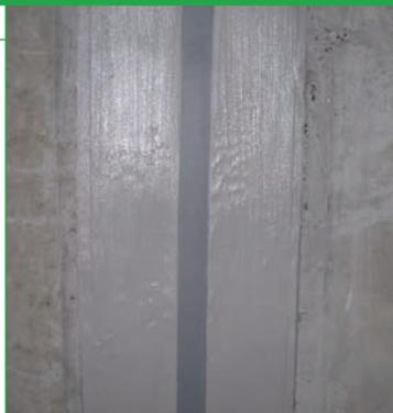
Двухкомпонентный тиксотропный эпоксидный клей для приклеивания лент Mapeband, Mapeband TRE, лент из ПВХ и Хайпалона (Hypalon) и для структурного склеивания бетона.
