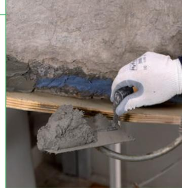
**Мелкозернистая тиксотропная армированная фиброй ремонтная смесь средней прочности (30 Н/мм<sup>2</sup>) с контролируемой усадкой для ремонта бетона.**
