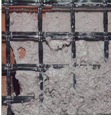
Двухкомпонентный, высокоэластичный состав на основе гидравлической извести и эко-пуццолановой добавки, для структурного усиления кирпичных кладок в системе с сетками **Mapegrid G 120** и **Mapegrid G 220** и для выравнивания оснований из бетона, камня, кирпича и туфа.
