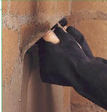
Двухкомпонентный, высокоэластичный, пуццолановый цементный состав для структурного усиления кирпичных кладок в системе с сетками **Mapegrid G 120** и **Mapegrid G 220** и для выравнивания оснований из бетона, камня, кирпича и туфа. Максимальная толщина слоя 6 мм.
