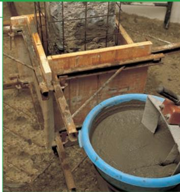
**Безусадочная быстротвердеющая ремонтная смесь наливного типа, содержащая полимерную фибру, предназначенная для ремонта бетонных и железобетонных конструкций.**
