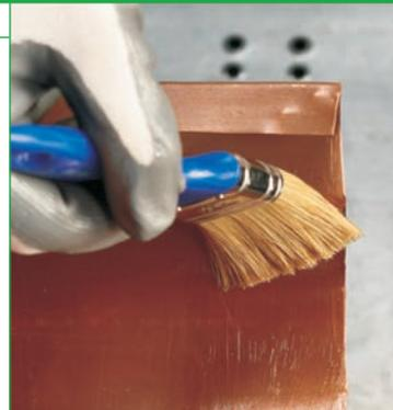
Однокомпонентный полиуретановый грунтовочный состав, не содержащий растворителя, для невпитывающих поверхностей.
