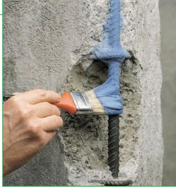
**Двухкомпонентный состав для защиты стальной арматуры от коррозии.**
