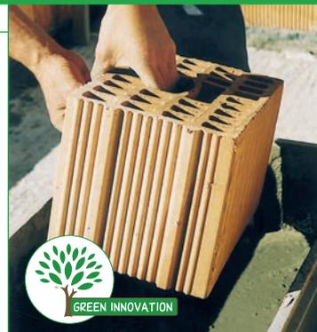
**Быстрохватывающийся состав для беспустотной укладки кирпичей и пеноблоков**
