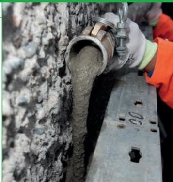
Высокоподвижная, армированная неорганической фиброй ремонтная смесь с компенсированной усадкой, для ремонта бетона, при необходимости применения состава с высокой степенью подвижности.
