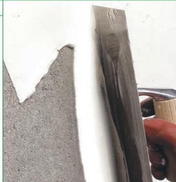
Выравнивающая шпаклевка на основе белой извести и гипса для выравнивания сухого, затвердевшего гипса, ангидрита или известково-цементных штукатурок внутри помещений.
