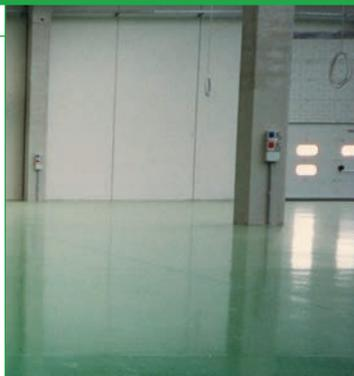
**Двухкомпонентная вододисперсионная эпоксидная краска для защиты цементных оснований.**
