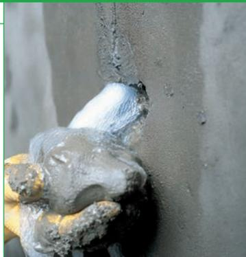
**Сверхбыстротвердеющее и быстро отверждающееся гидравлическое вяжущее для остановки водных протечек.**
