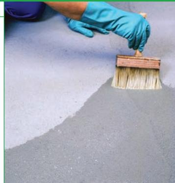
**Двухкомпонтный эпоксидный вододисперсионный пленкообразующий состав для бетона, дополнительно обладающий укрепляющими и обеспылевающими свойствами.**
