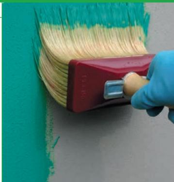
Вододисперсионная акриловая краска с тонкомолотым кварцевым наполнителем для наружных и внутренних работ.
