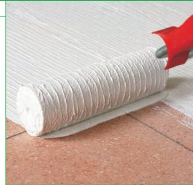
**Трёхкомпонентный грунтовочный состав на основе эпоксидной смолы и цемента для влажных поверхностей.**
