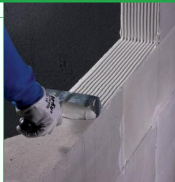
**Однокомпонентный мелкозернистый цементный состав белого цвета для укладки и последующего выравнивания блоков из ячеистого бетона. Толщина слоя до 10 мм. Класс огнестойкости в соответствии с UNI EN 1364-1 EI 240 — E 120**
