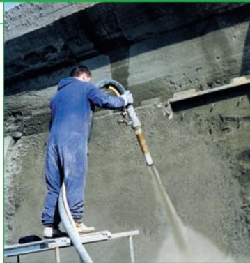
**Однокомпонентная цементная ремонтная смесь без ускорителей схватывания для ремонта бетона методом сухого или мокрого торкретирования.**
