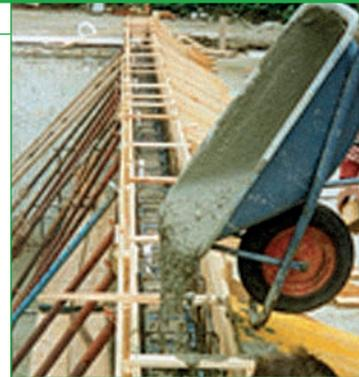
**Безусадочная быстротвердеющая бетонная смесь наливного типа, содержащая полимерную фибру, предназначенная для ремонта бетонных и железобетонных конструкций. Толщина от 40 до 100 мм.**
