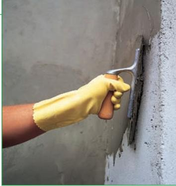
**Однокомпонентный цементный состав с обычным временем схватывания для выравнивания бетонных поверхностей и цементной штукатурки.**
