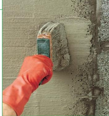
**Осмотическая однокомпонентная жесткая цементная обмазочная гидроизоляция для кирпичных стен и бетонных конструкций.**
