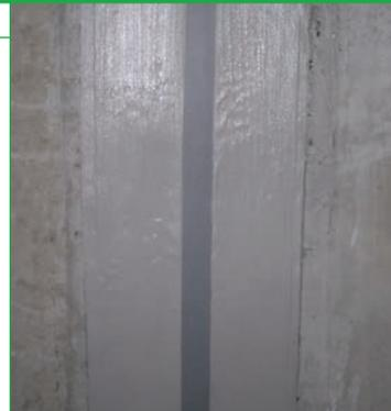
**Двухкомпонентный тиксотропный эпоксидный клей для приклеивания лент Mapecband, Mapecband TPE, лент из ПВХ, Хайпалона (Hypalon), для структурного склеивания бетона.**
