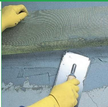
**Двухкомпонентный эластичный гидроизоляционный состав на цементной основе.**
