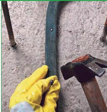
**Гидрорасширяющаяся бентонитовая соединительная лента для герметизации рабочих швов бетонирования.**
