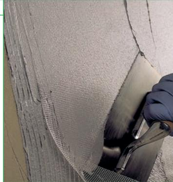
Однокомпонентная готовая к применению высокоэластичная шпатлевка с добавлением тонкомолотого песка, армированная фиброй для нанесения вручную, обладающая высокой заполняющей способностью.
