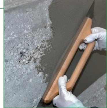
**Быстросхватывающийся выравнивающий состав на цементной основе для горизонтальных и вертикальных поверхностей внутри и снаружи помещений с толщиной нанесения от 3 до 30 мм.**
