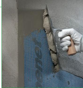
**Однокомпонентный цементный состав нормального схватывания для выравнивания оштукатуренных поверхностей и фактурных покрытий.**
