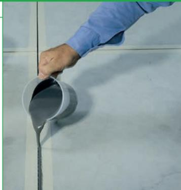
Двухкомпонентный самовыравнивающийся эпоксидно-полиуретановый герметик с высокой химической стойкостью и механической прочностью.
