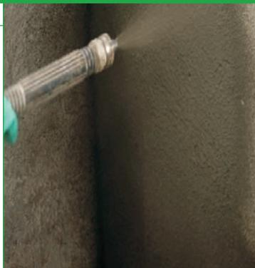
**Трёхкомпонентный эпоксидно-цементный тиксотропный состав для выравнивания влажных поверхностей.**
