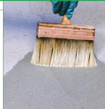
**Силан-силоксановая водоземлюльсионная грунтовка для защиты поверхностей от образования плесени и грибка.**
