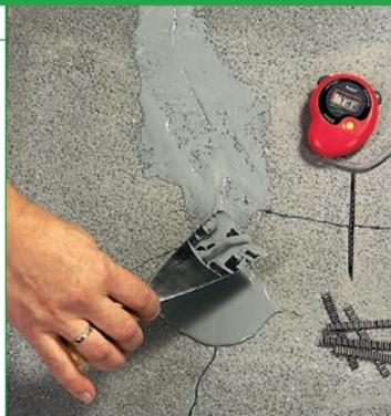
**Сверхбыстросхватывающаяся двухкомпонентная полиэфирная смола для герметизации трещин в стяжках и мелких ремонтных работ.**
