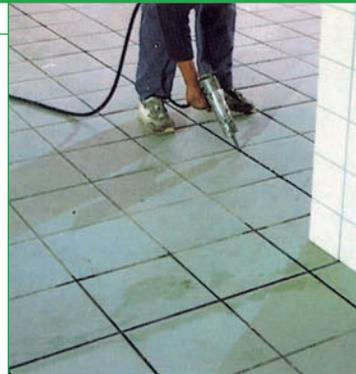
**Силиконовый герметик с ретикуляцией на уксусной основе, стойкий к плесени, изготовленный без использования растворителей.**
