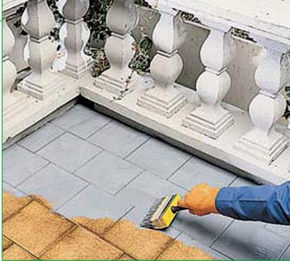
**Эластичная полимерная гидроизоляция для цементных и асбестоцементных оснований.**
