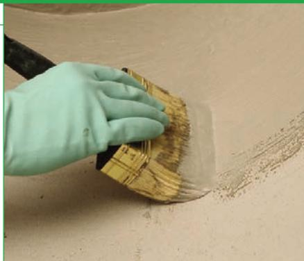
**Двухкомпонентный высокоэластичный цементный состав для гидроизоляции бетонных поверхностей и для защиты от воздействия агрессивных агентов.**
