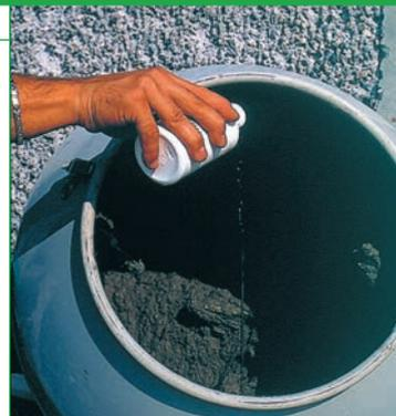
**Добавка, для снижения влажностной усадки и предотвращения появления микротрещин.**
