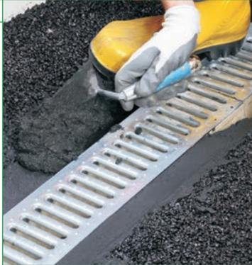
**Быстрохватывающаяся и быстротвердеющая тиксотропная ремонтная смесь с компенсированной усадкой, применяемая для ремонта бетона и монтажа дренажных труб, канализационных люков и городских декоративных элементов.**
