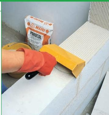
**Цементный кладочный состав для блоков из ячеистого бетона.**
