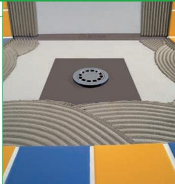
**ПВХ-лента для жидких гидроизоляционных мембран.**
