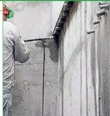
**Двухкомпонентная полиуретановая инъекционная смола повышенной вязкости со сверхбыстрым временем схватывания для консолидации и гидроизоляции конструкций, подверженных сильным протечкам воды под высоким давлением.**
