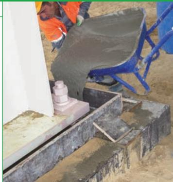
**Безусадочная, быстротвердеющая бетонная смесь наливного типа, предназначенная для высокопрочной фиксации оборудования, колонн, омоноличивания стыков железобетонных конструкций.**
