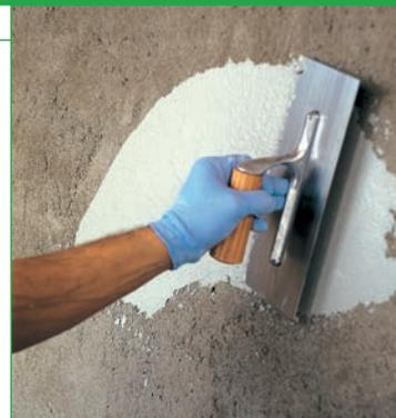
**Белая известково-цементная шпатлевка для финишного, особо гладкого выравнивания как свежих, так и затвердевших штукатурок при наружных и внутренних работах, наносится слоем толщиной 0-3 мм.**
