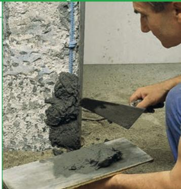
Быстротвердеющая ремонтная смесь с компенсированной усадкой, тиксотропного типа, содержащая полимерную фибру, предназначенная для ремонта бетонных и железобетонных конструкций.
