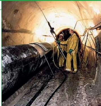
**Двухкомпонентная полиуретановая инъекционная смола со сверхбыстрым схватыванием для консолидации и гидроизоляции конструкций, подверженных слабым протечкам.**
