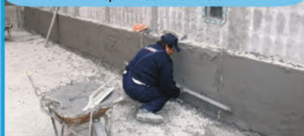
Выравнивание стен бассейна с применением Nivoplan Plus + Planicrete
