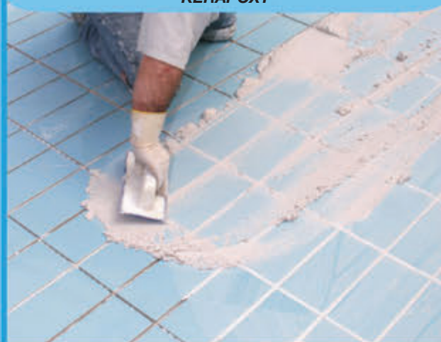
Заполнение швов шовным заполнителем KERAPOXY
