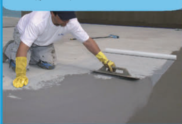
Гидроизоляция составом MAPELASTIC
