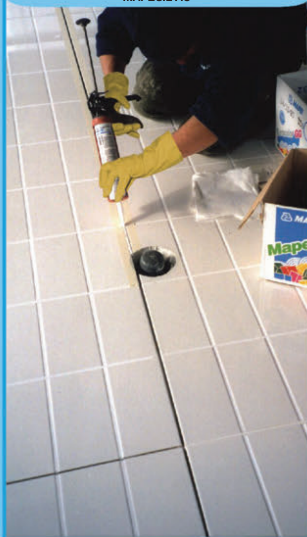
Заполнение швов с помощью герметика MAPESIL AC
