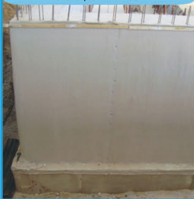
Стенка бассейна, гидроизолированная с помощью MAPEPROOF
