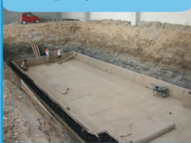
Укладка материала MAPEPROOF
