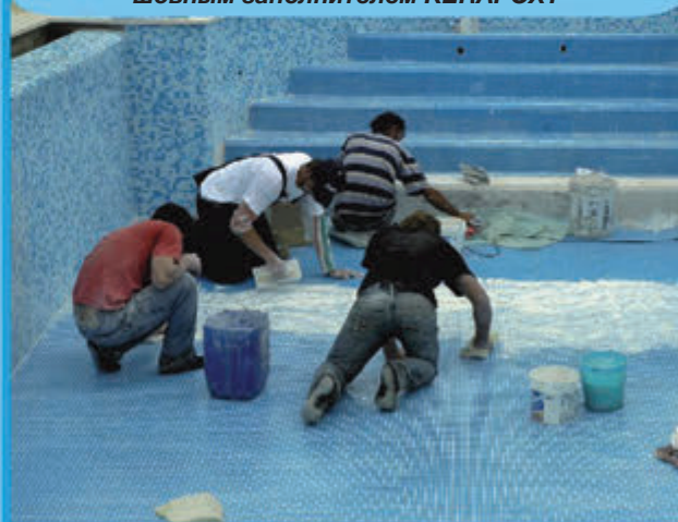
Заполнение швов в стеклянной мозаике шовным заполнителем KERAPOXY
