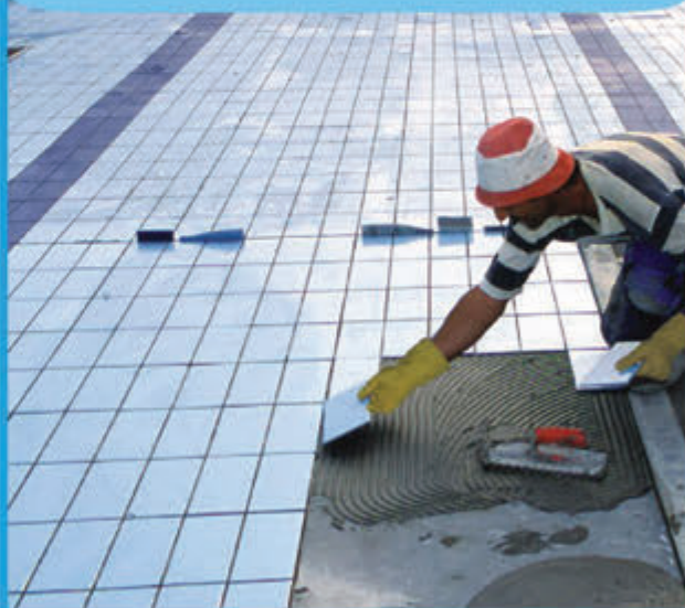
Укладка плитки на MAPELASTIC с использованием KERABOND + ISOLASTIC
