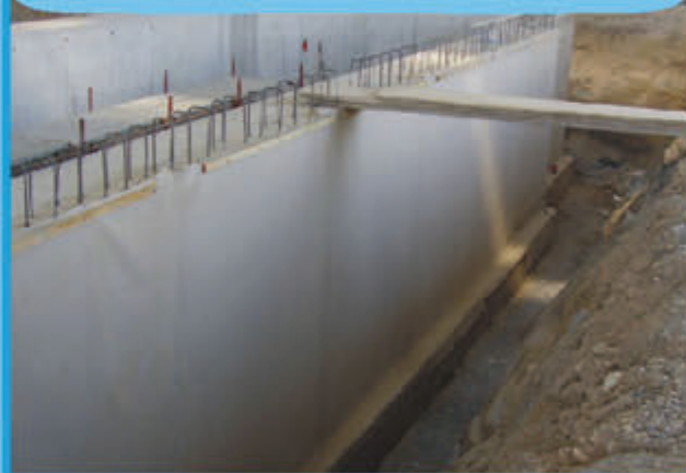
Гидроизоляции стенок бассейна с использованием MAPEPROOF
