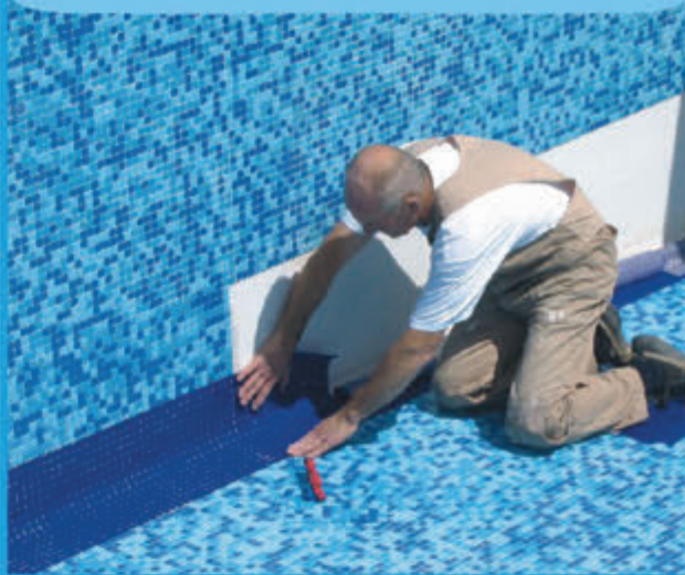
Укладка стеклянной мозаики на ADESILEX P10 + ISOLASTIC
