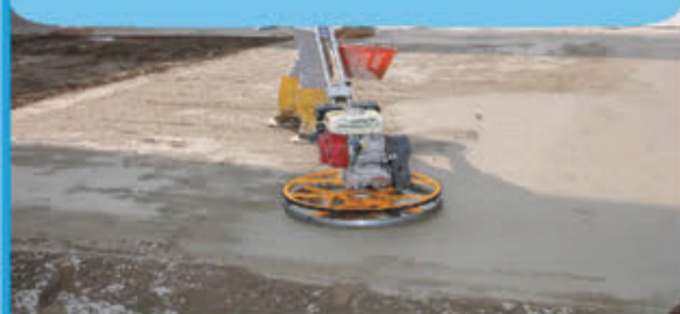
Шлифование поверхности стяжки
