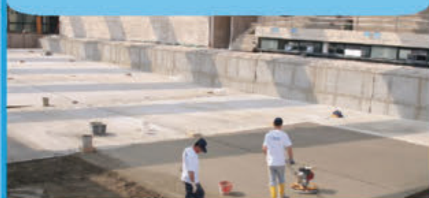
Изготовление стяжки
