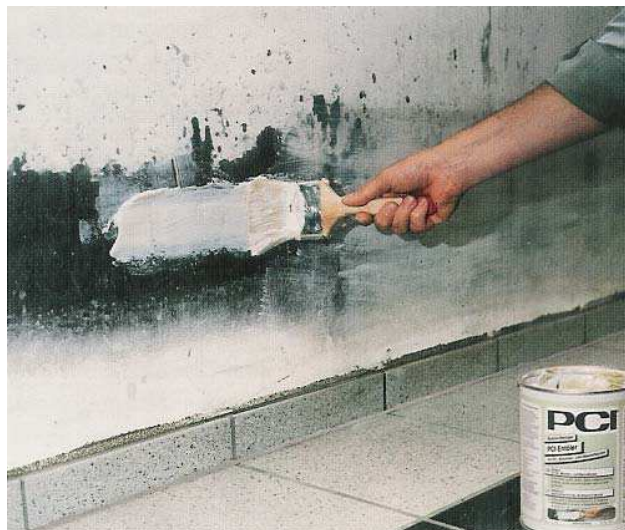
Применение пасты PCI Entoeler на загрязненном битумом основании
