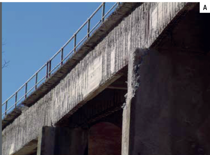
фото 24 А Бетонное сооружение до ремонта
