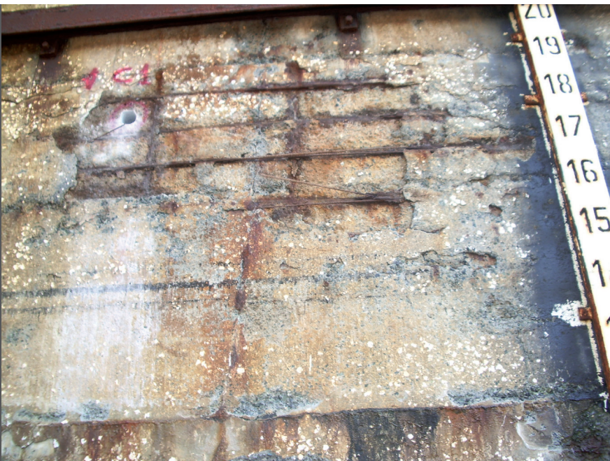
фото 10 Коррозия в результате воздействия хлоридов
