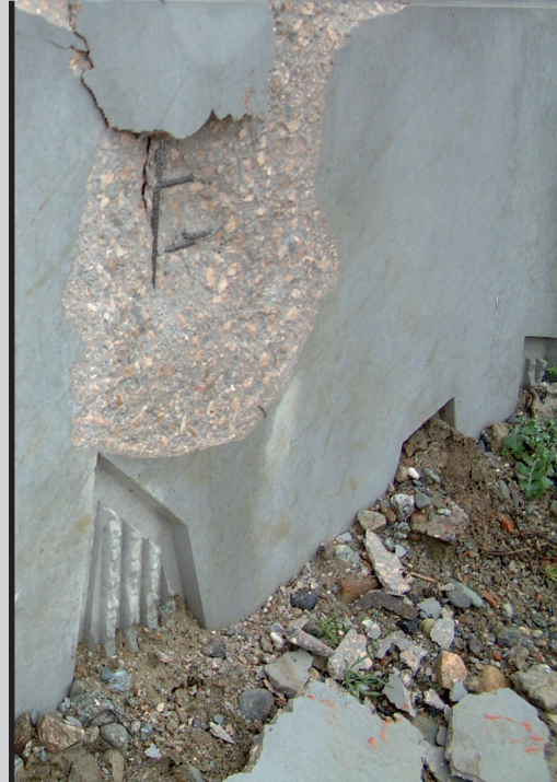
фото 15 Разрушение в результате замерзания
