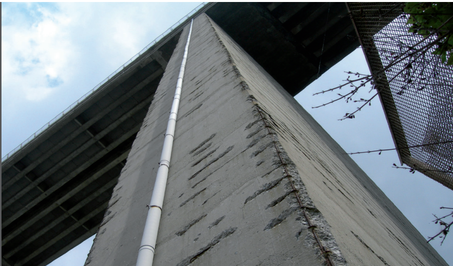
фото 3 Пример разрушения, вызванного внешней средой
