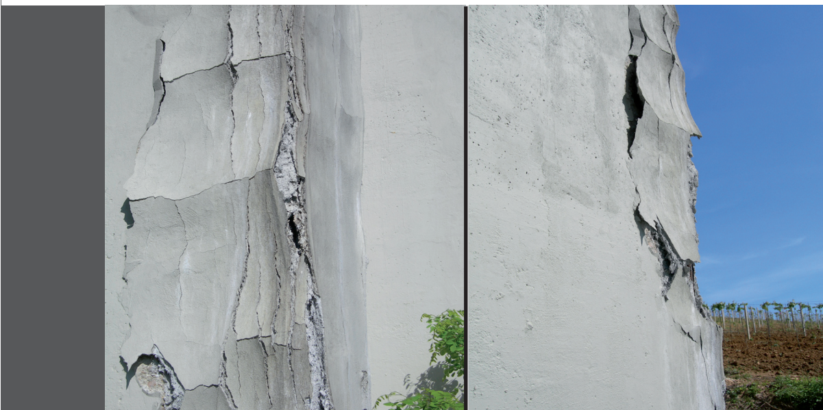
фото 7/8 Пример сооружения, поврежденного в результате агрессивного воздействия сульфатов
