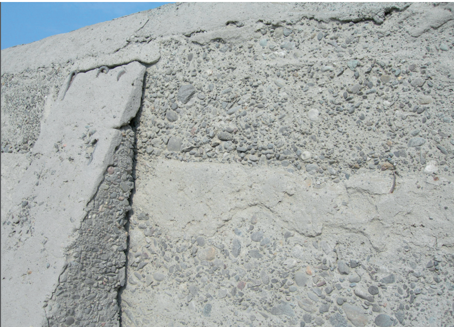
фото 5 Влияние на поверхность бетона выщелачивания
