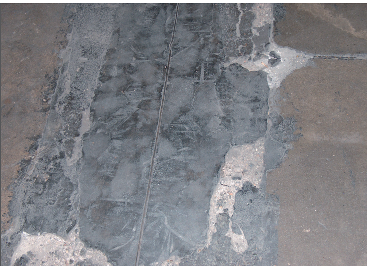
фото 20 Разрушенный бетон
