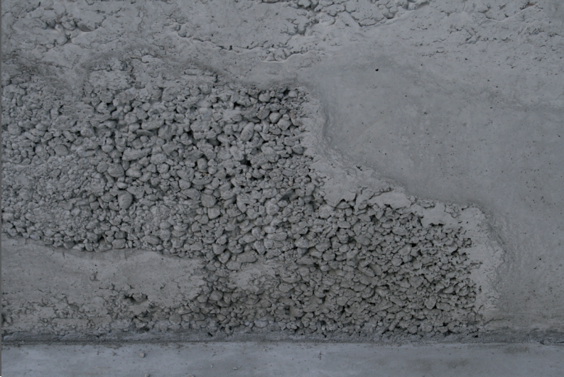
фото 21 Разделение заполнителей в бетоне
