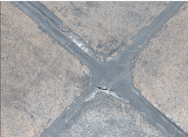
фото 19 Пример разрушения в стыках
