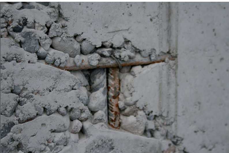
фото 22 Открытые арматурные стержни в бетоне
