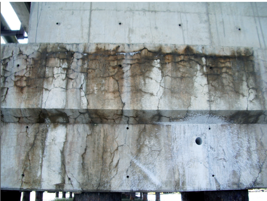
фото 11 Разрушение из-за реакции взаимодействия щелочей цемента с заполнителями бетона
