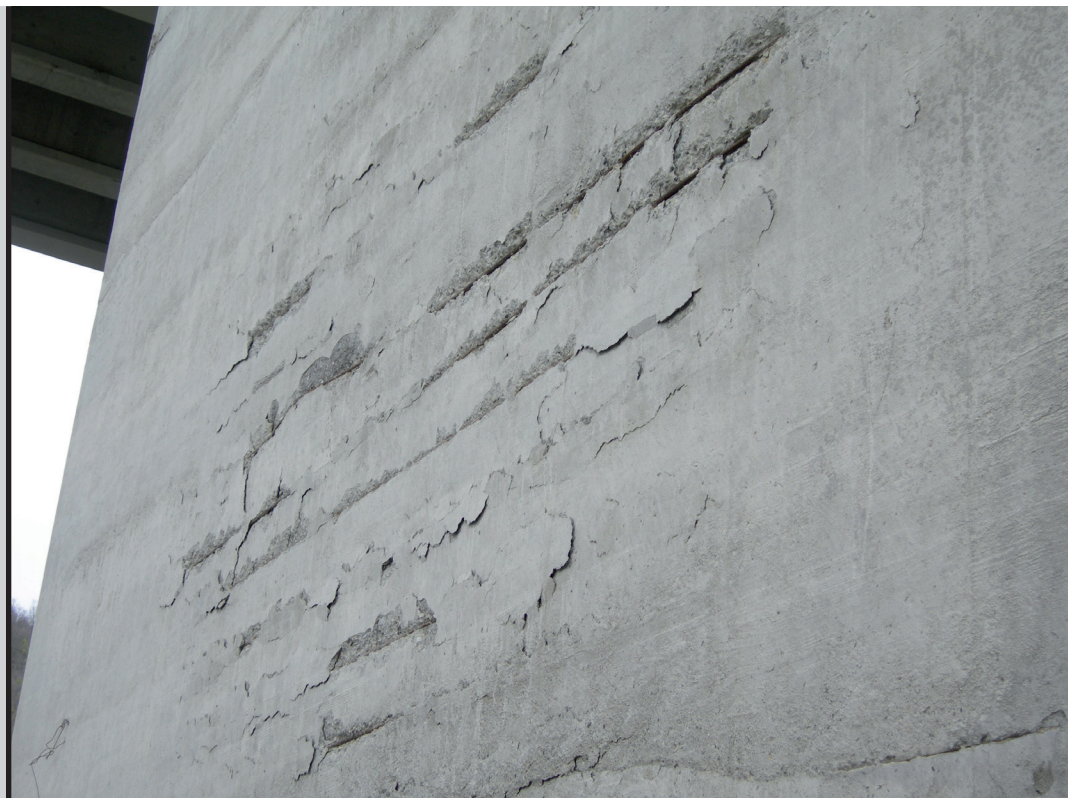
фото 4 Разрушение сооружения вследствие коррозии арматурных стержней
