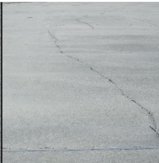
фото 16 Трещина в бетоне
