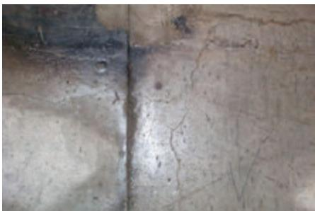
**Рис. 2.** Усадочные трещины на поверхности стены автодорожного тоннеля
