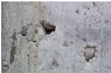
**Рис. 1.** Зависание бетонной смеси в зоне «сухарей»
