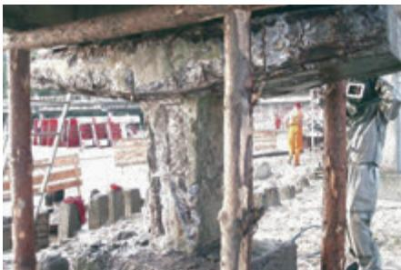
**Рис. 3. Разрушение бетона маломассивной опоры с оголением и коррозией арматуры**
