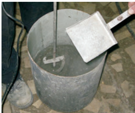
Рисунок П1 Приготовление ремонтного состава Marergout Thixotropic
