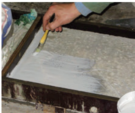
Рисунок П3 Нанесение адгезионного состава марки Epoip на поверхность бетонного основания
