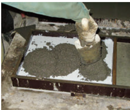
Рисунок П4 Укладка ремонтного материала АРБ-10Ф
